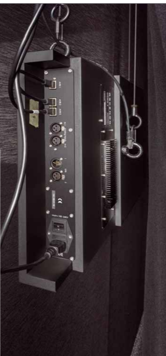
Zwischen den beiden Lagen Akustikgewebe hängen die Monitore am Fluggeschirr. Die Lautsprecher werden mit Netzwerkkabeln miteinander verknüpft. Lautsprecherkabel sind keine notwendig
